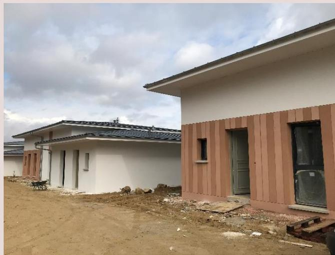
Les **menuiseries extérieures** sont bien engagées dans le Bâtiment B et C. Le **ravalement** du Bâtiment C et des maisons est en cours.
